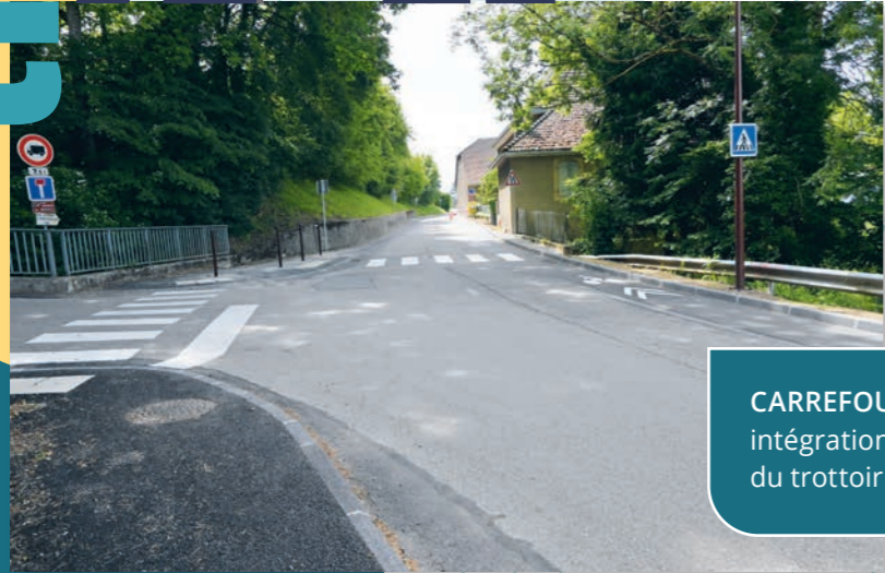
CARREFOUR AVEC LE CHEMIN DU CHÂTEAU ET LE CHEMIN DE SAINT-GRAT : création d'un plateau surélevé pour ralentir la vitesse et intégrer un passage piéton. Départ du trottoir route de Bellevue en direction de Milly.
