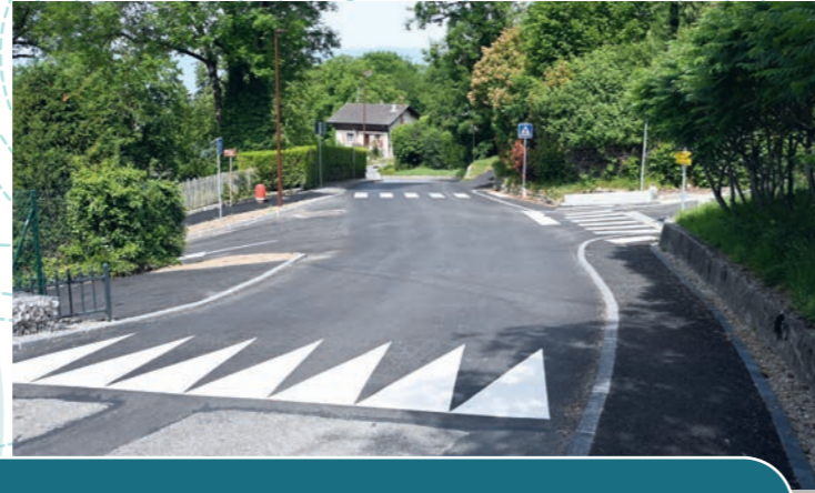
CARREFOUR AVEC LE CHEMIN DU CHÂTEAU ET LE CHEMIN DE SAINT-GRAT : création d'un plateau surélevé pour ralentir la vitesse et intégrer un passage piéton. Départ du trottoir route de Bellevue en direction de Milly.
