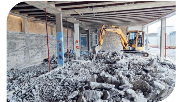
L'ancien préau a été remplacé par un hall d'entrée, des sanitaires pour les élémentaires et une salle de classe pour les maternelles. Cela représente des travaux importants car le dallage devait être démolé afin d'isoler thermiquement le sol.
