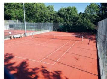
Cette année, le deuxième court a été refait à neuf : création d'une dalle en béton poreux et mise en place d'un nouveau revêtement type Topsand aiguilleté. Les équipements ont également été changés (poteaux, filet...).
