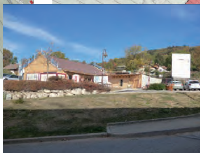
Future salle communale, en cours de construction
