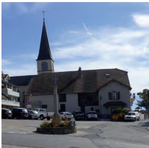
Maison Louise abritant un restaurant et un bar-tabac
